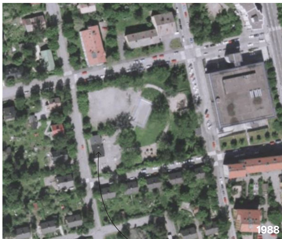
Leikkipuistorakennuksen laajennus tehtiin 1984
