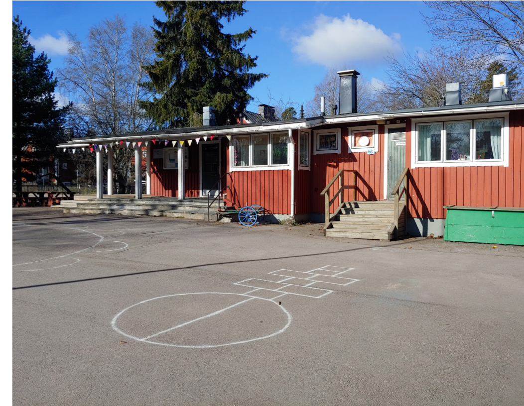
Leikkipuistorakennuksen ympäristö on aidattu rakennuksen peruskorjauksen vuoksi
