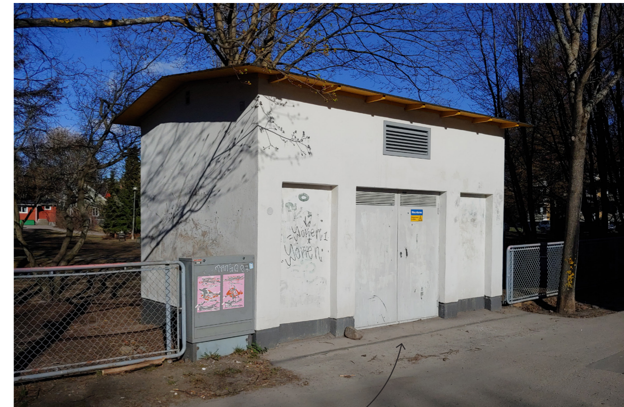
Puistossa, Turjontien reunalla on muuntamorakennus
